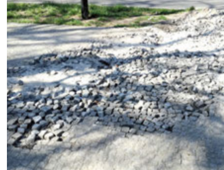
Pl. Grunwaldzki - uszkodzona nawierzchnia alejki
